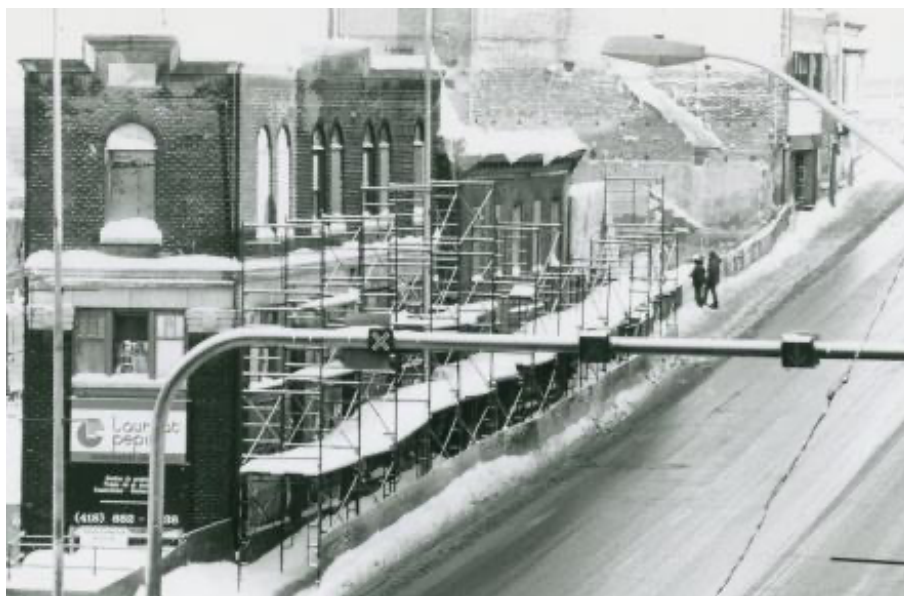
Figure 1 : 1994 Chantier, Méduse. Tous droits réservés.
